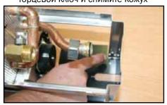
**6.** Выход из арматуры оборотной воды-теплоносителя
