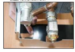
**9.** Подключите угловой клапан к выходу оборотной воды
