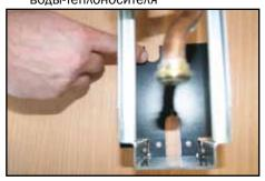
**8.** Подключите угловой клапан к выходу оборотной воды
