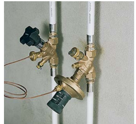
Подключение регулирующей арматуры на стояках
