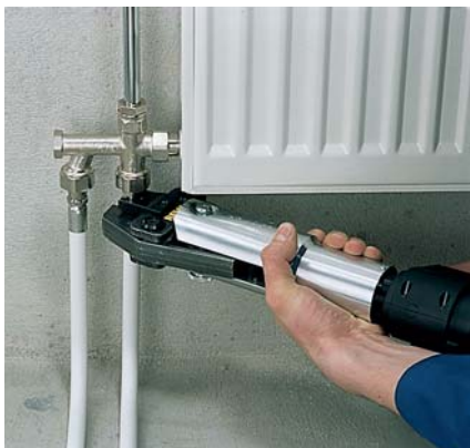
Напольное подключение с помощью присоединительных насадок для одно- и двухтрубных систем
