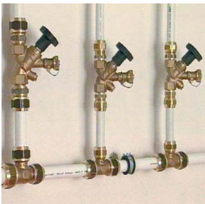
Монтаж арматуры с резьбовым соединением
