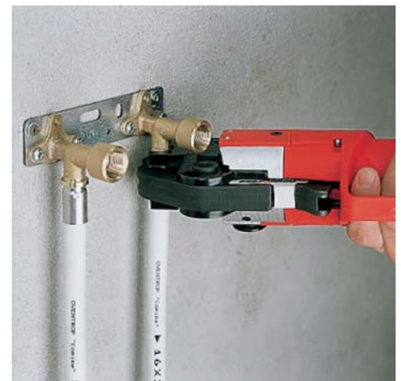
Прессовое соединение на монтажной шине
