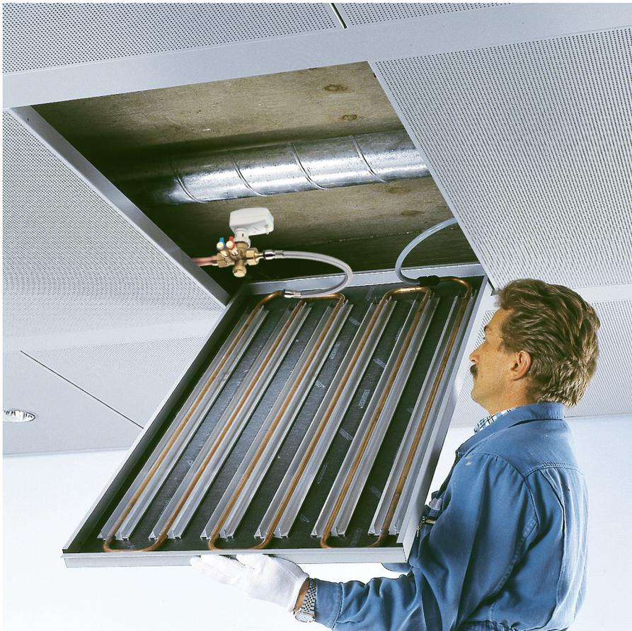
В области охлаждения помещений в административных зданиях все большую роль играют панельные потолочные системы, причем эти системы в определенных рамках можно использовать и для отопления.
