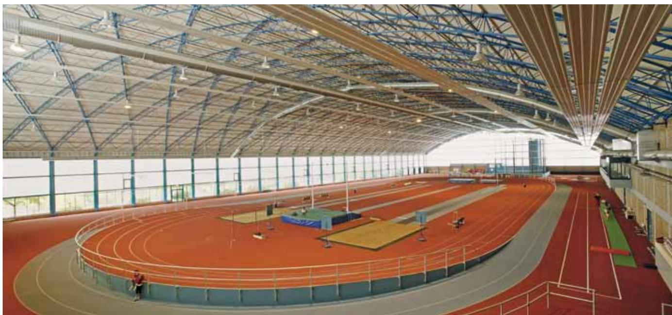
Ввиду большой площади стеклянных фасадов новая система отопления должна была обеспечивать круглогодичную эксплуатацию здания. Система потолочных излучающих панелей Zehnder ZIP справилась и с этой задачей.
