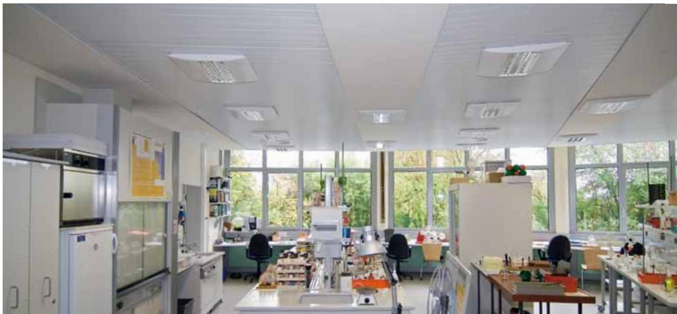
Эта система вместе с системой вентиляции также была установлена в классе химии. Решетки для приточного и вытяжного воздуха были встроены непосредственно в панели в исполнении «парус», а светильники были прикреплены к ним.
