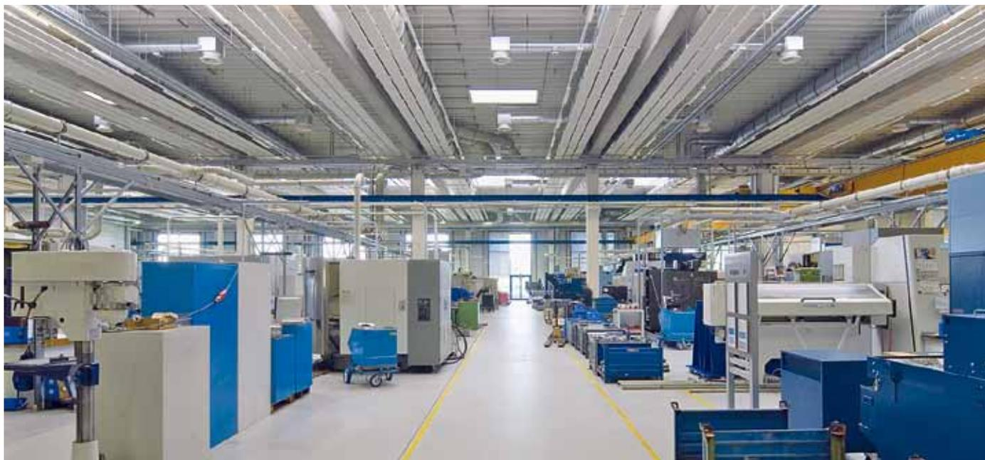
В зависимости от отдела и особенностей эксплуатации применялись системы Zehnder ZIP или Zehnder Como. В потолочные панели Zehnder Como, встроенные в подвесной потолок, были интегрированы вентиляционные решетки и осветительные приборы.
