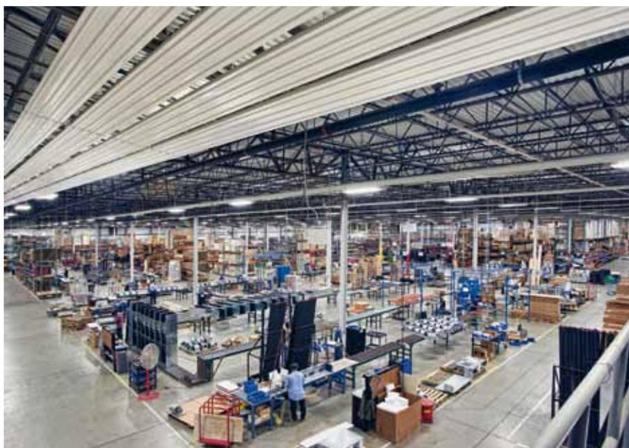
Были использованы излучающие панели типа Zehnder ZIP. На производственной площади 13 000 м<sup>2</sup> и офисной площади 1850 м<sup>2</sup> были смонтированы панели общей длиной 1800 м, частично на высоте до 30 м.
