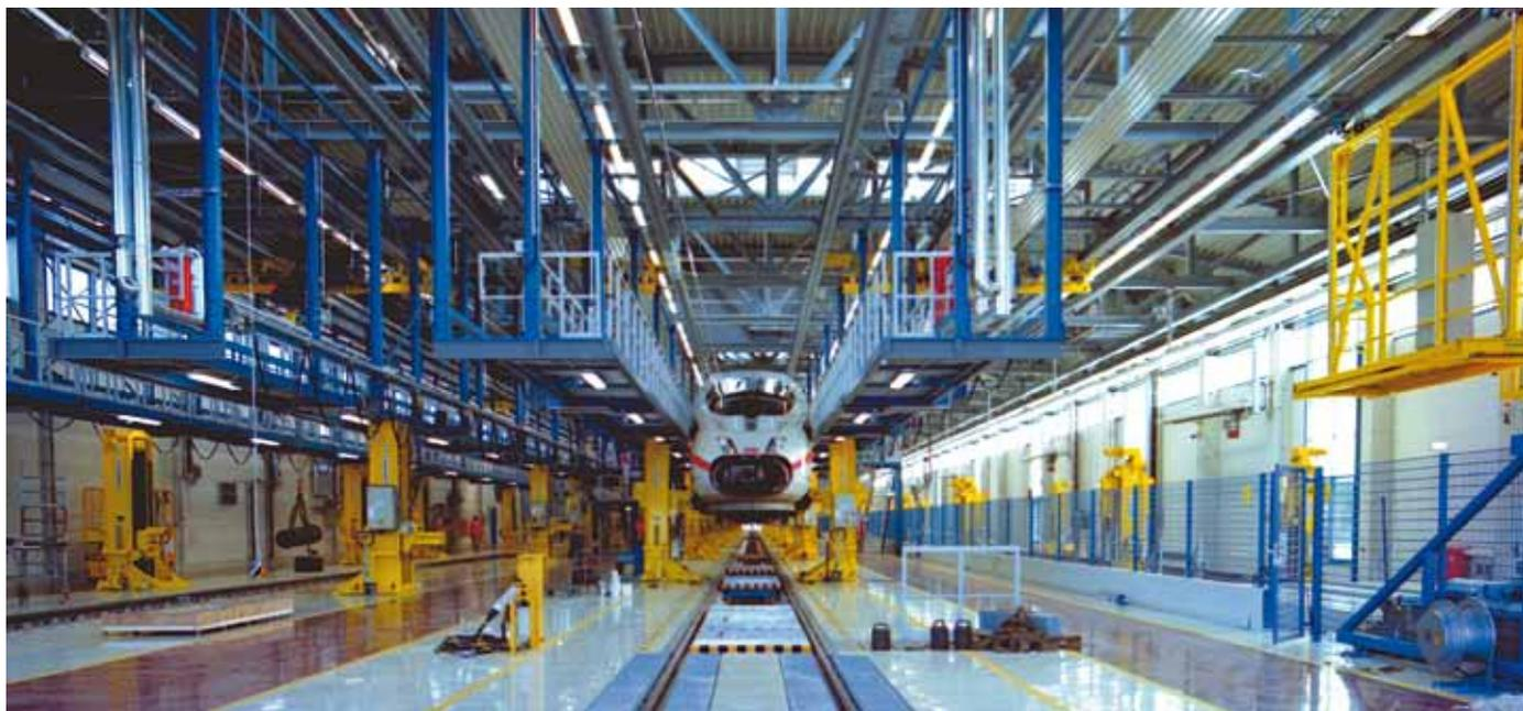
Всего было смонтировано 39 модулей излучающих панелей общей длиной 1147 м. Размещение этих панелей потребовало некоторой сноровки, чтобы они не пересекались с кран-балками, проложенными по всей длине помещения с тремя ремонтными колеями.
