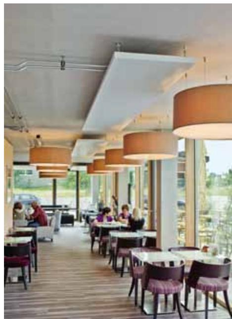
Во всех помещениях офиса, включая кафетерий, микроклимат поддерживается с помощью панелей Zehnder Carboline. Легкие панели, при изготовлении которых используется природный графит, обеспечивают особенно быстрое, равномерное и эффективное распределение температуры.
