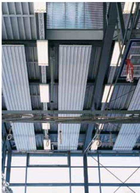
Когда в солнечную погоду зал быстро нагревается за счёт инсоляции, потолочные панели Zehnder моментально реагируют на повышение внутренней температуры благодаря небольшой инерционной массе. Таким образом тепловая мощность панелей быстро подстраивается под изменения тепловой обстановки. И это неудивительно: потолочные панели Zehnder являются настоящими профессионалами в вопросах экономичности и технологий, когда речь идет об отоплении больших залов.
