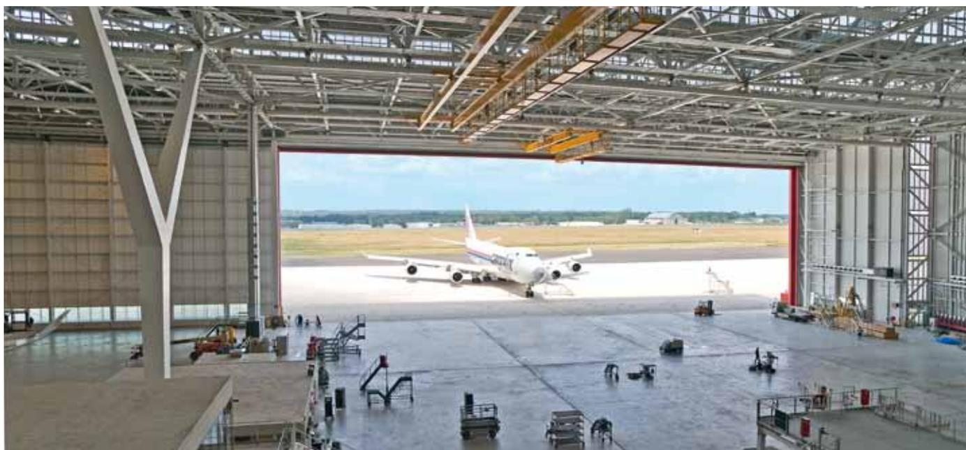
17 000 м<sup>2</sup> площади и потолки высотой до 42 м – серьезный вызов системе Zehnder ZBN. Принцип теплового излучения имеет здесь большое значение, так как тепло требуется именно в нижней части помещения.
