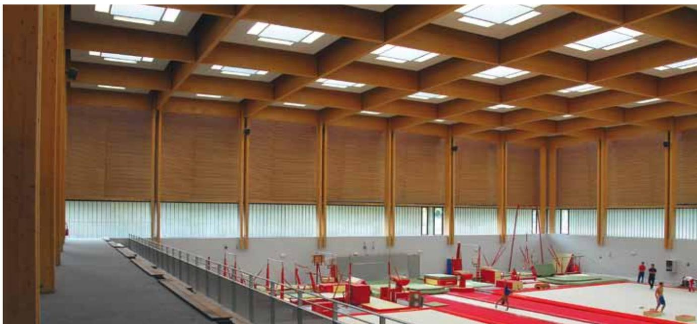
12 000 м<sup>2</sup> этого здания оснащены потолочными излучающими панелями Zehnder Reverse. В общей сложности 1836 м<sup>2</sup> потолочных излучающих панелей служат для обрамления фонарей дневного света.
