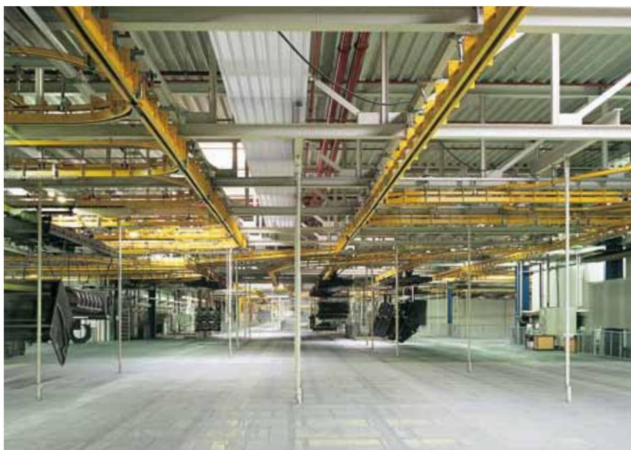
В новых сборочных цехах в общей сложности было установлено 419 элементов потолочных излучающих панелей Zehnder. Панели удалось без каких-либо сложностей согласовать с комплексной производственной линией полностью автоматизированного покрасочного цеха.
