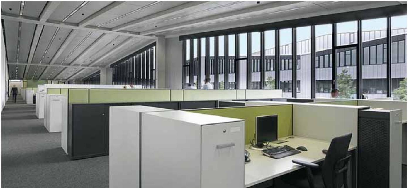
Потолочные панели Zehnder Carboline в исполнении «парус» обеспечивают комфортный микроклимат несмотря на стеклянные фасады здания. Одновременно с этим они обеспечивают комфортную акустику благодаря звукопоглощающему эффекту.
