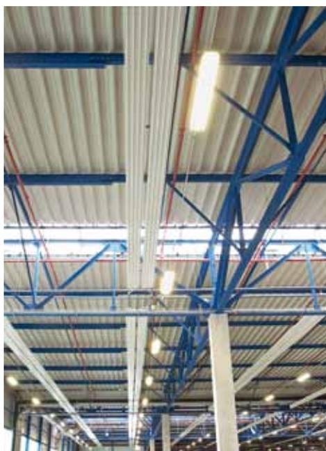
При выборе климатической системы было принято решение в пользу производительности и эффективности, а именно в пользу системы потолочных излучающих панелей Zehnder. Всего было установлено 19 км излучающих панелей типа Zehnder ZIP.
